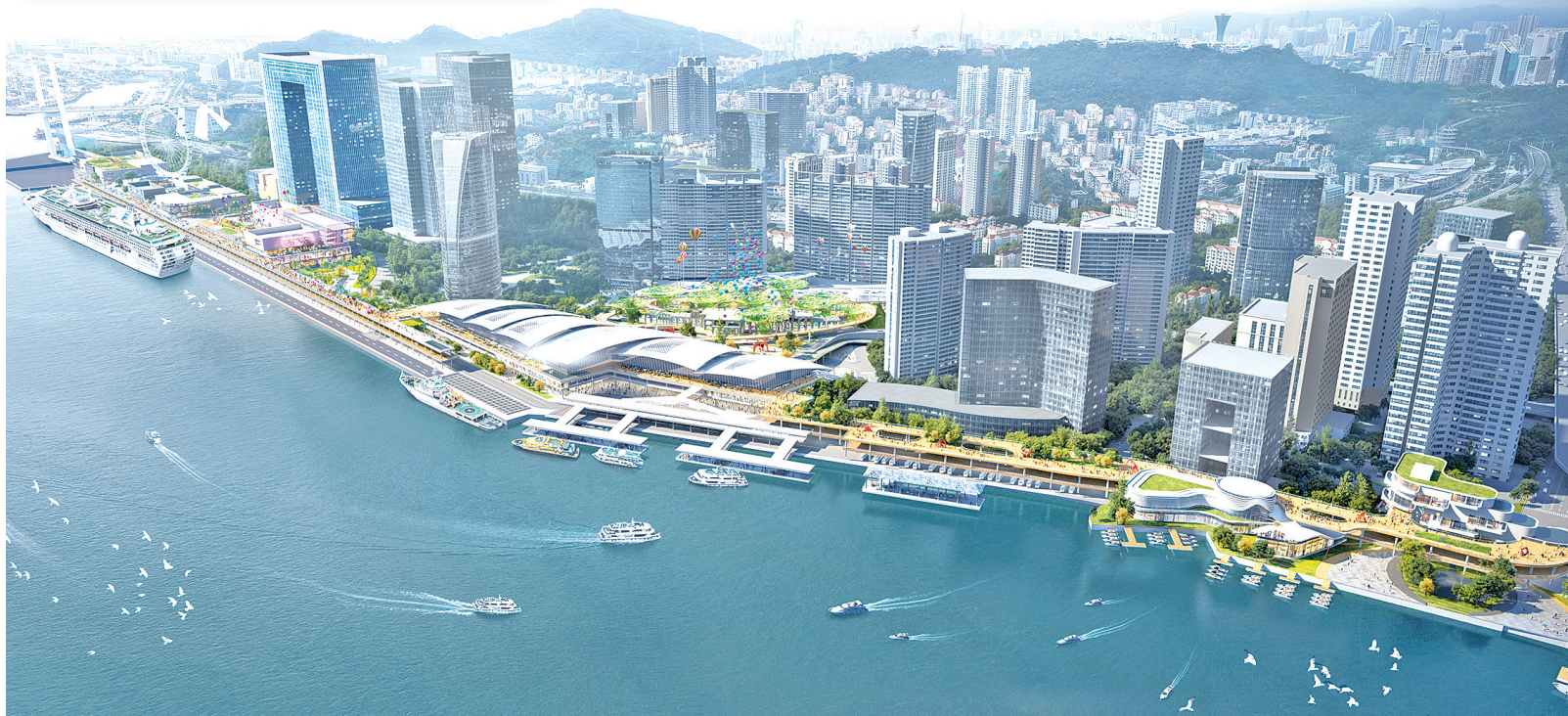
厦门文商旅综合体“屿见时光”项目地处东渡邮轮中心片区。(项目区位总览图)
