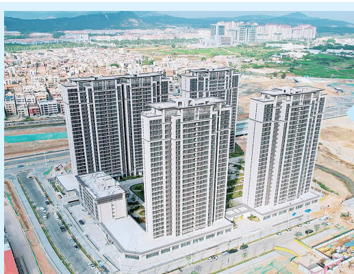
东园公寓一期已完成预验收。
