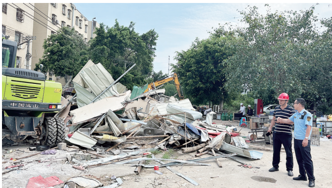
翔安区民安街道不断挺进拆违“深水区”。通讯员供图
