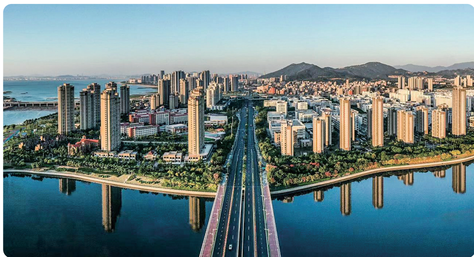
同安区提升基层治理水平,为富美新同安高质量发展提供坚强组织保障。夏海滨摄
