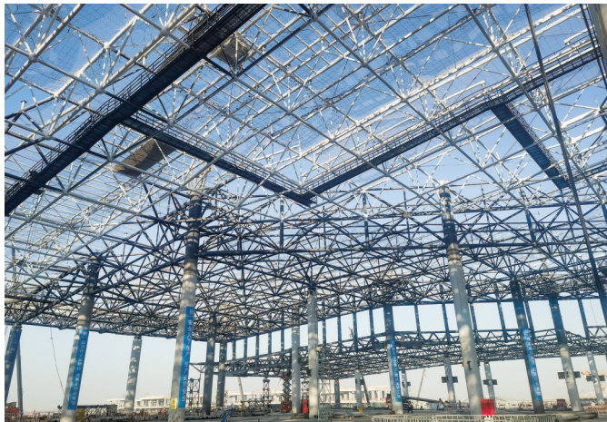
厦门翔安机场航站楼钢结构屋盖合拢。
