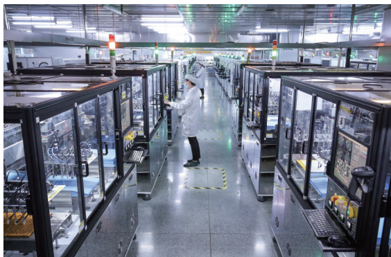
弘信电子厦门翔海厂钢片贴合机。企业供图
