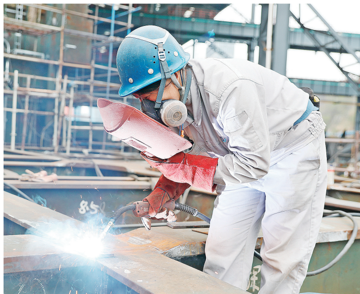
茂元娇在进行汽车滚装船组装焊接。记者 陈理杰 摄
