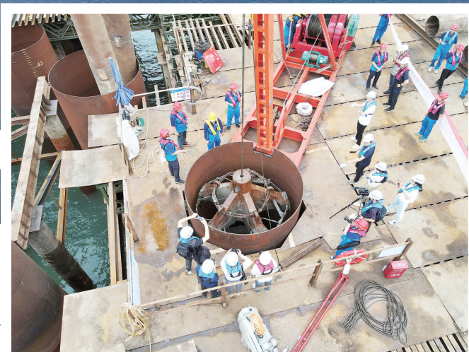
刘五店悬索桥主塔首根桩基正式开钻。 记者 陈理杰 摄
