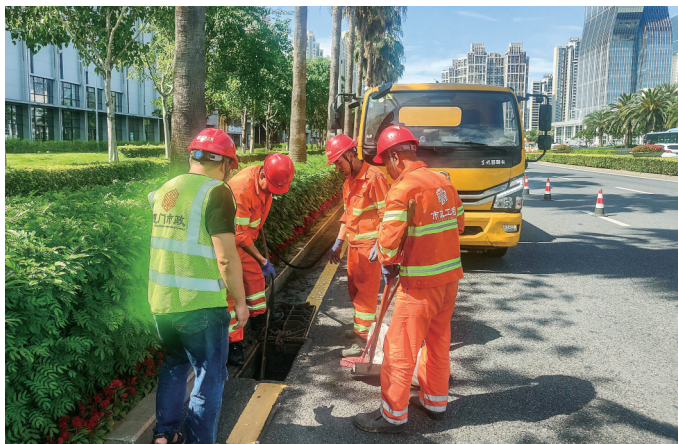
施工人员在进行道路易积水点改造。
