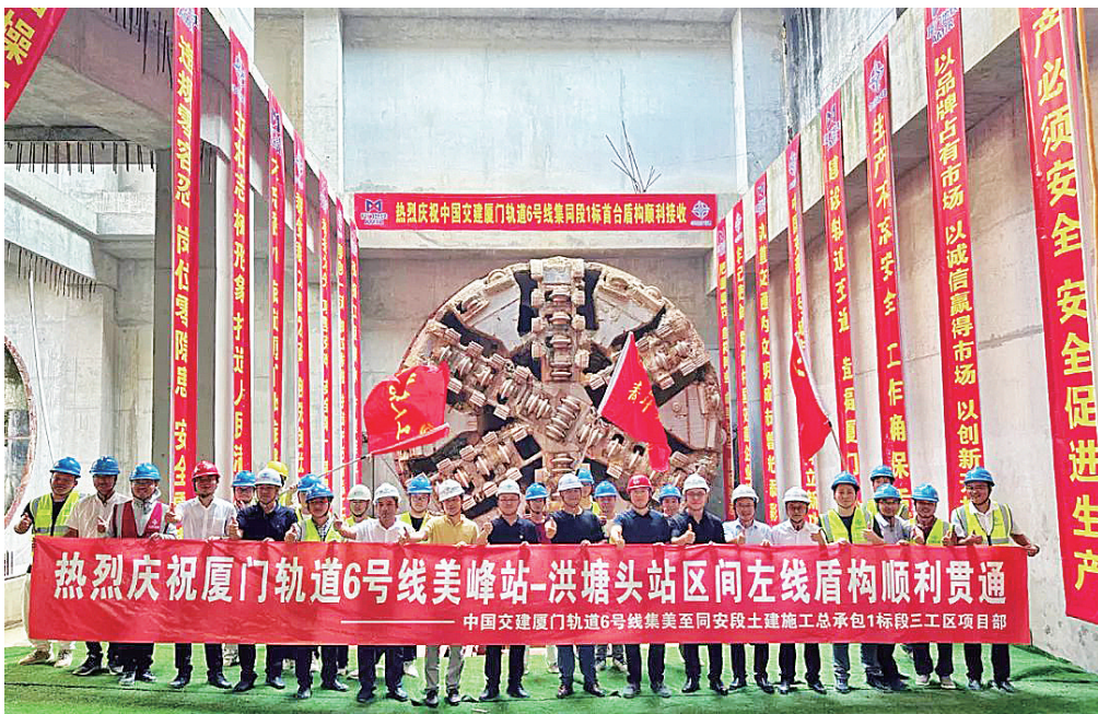
厦门地铁6号线集同段美洪区间左线实现贯通。
