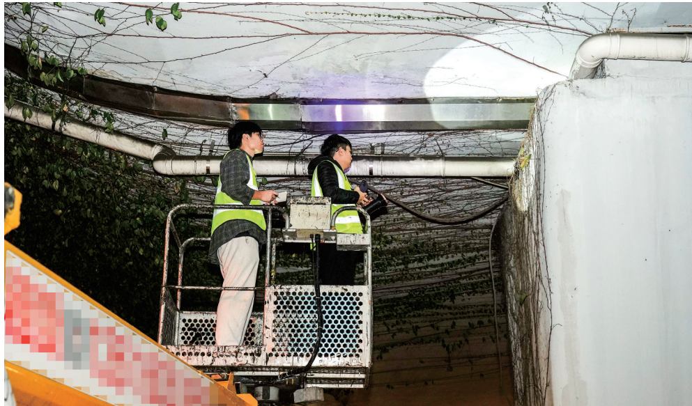
专业检测团队对仙岳高架桥进行检测。记者 王世伟摄
