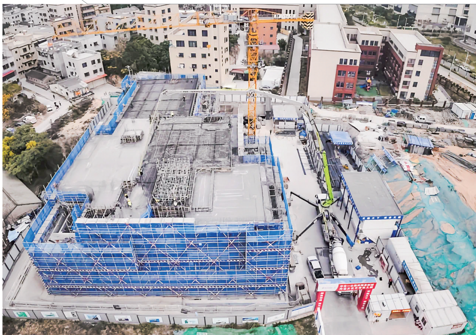
布塘幼儿园主体结构封顶。
