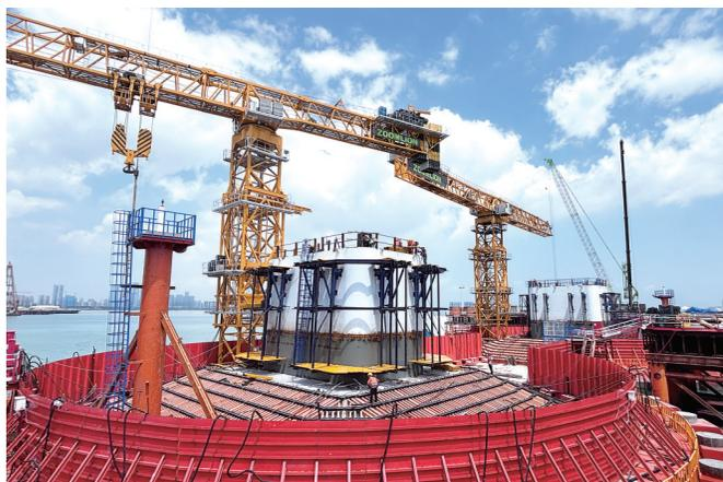
东主塔塔体两个节段吊装已完成。记者 张玲玲 摄
