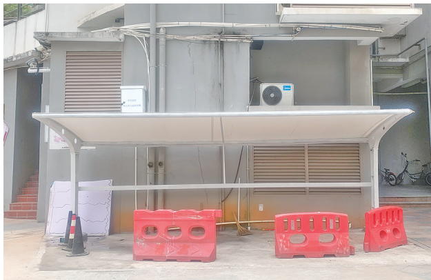
电动自行车棚已停止施工。记者 刘宇瀚 摄
