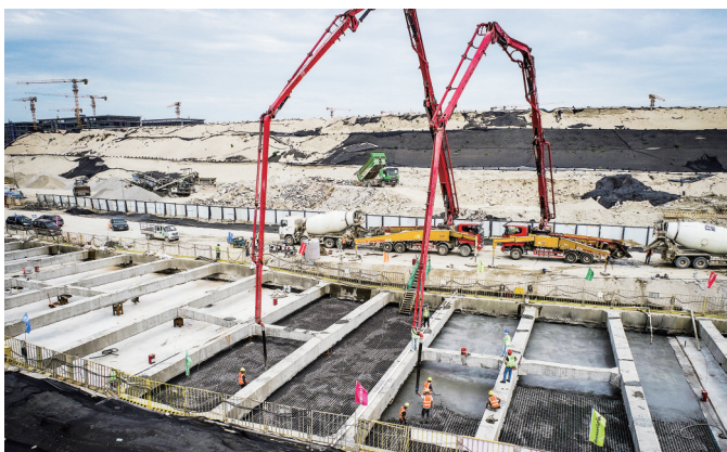
厦门翔安国际机场航站区陆侧交通工程总投资9.1亿元,总长度2.8公里。
