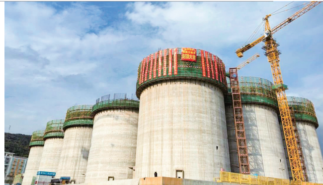
翔安粮库三期工程30个浅圆仓穹顶全面封顶。
