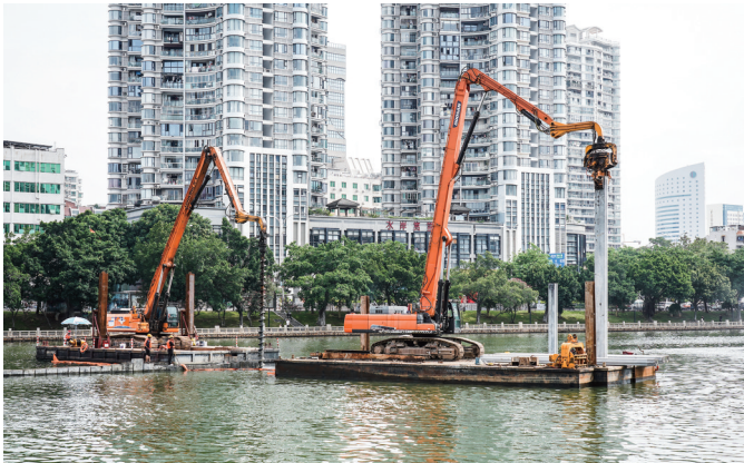
施工现场,工人正在湖中打板桩。记者 王世伟 摄
