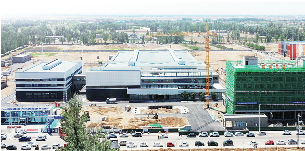
厦门钨业稀土永磁材料项目建设刷新进度条。
