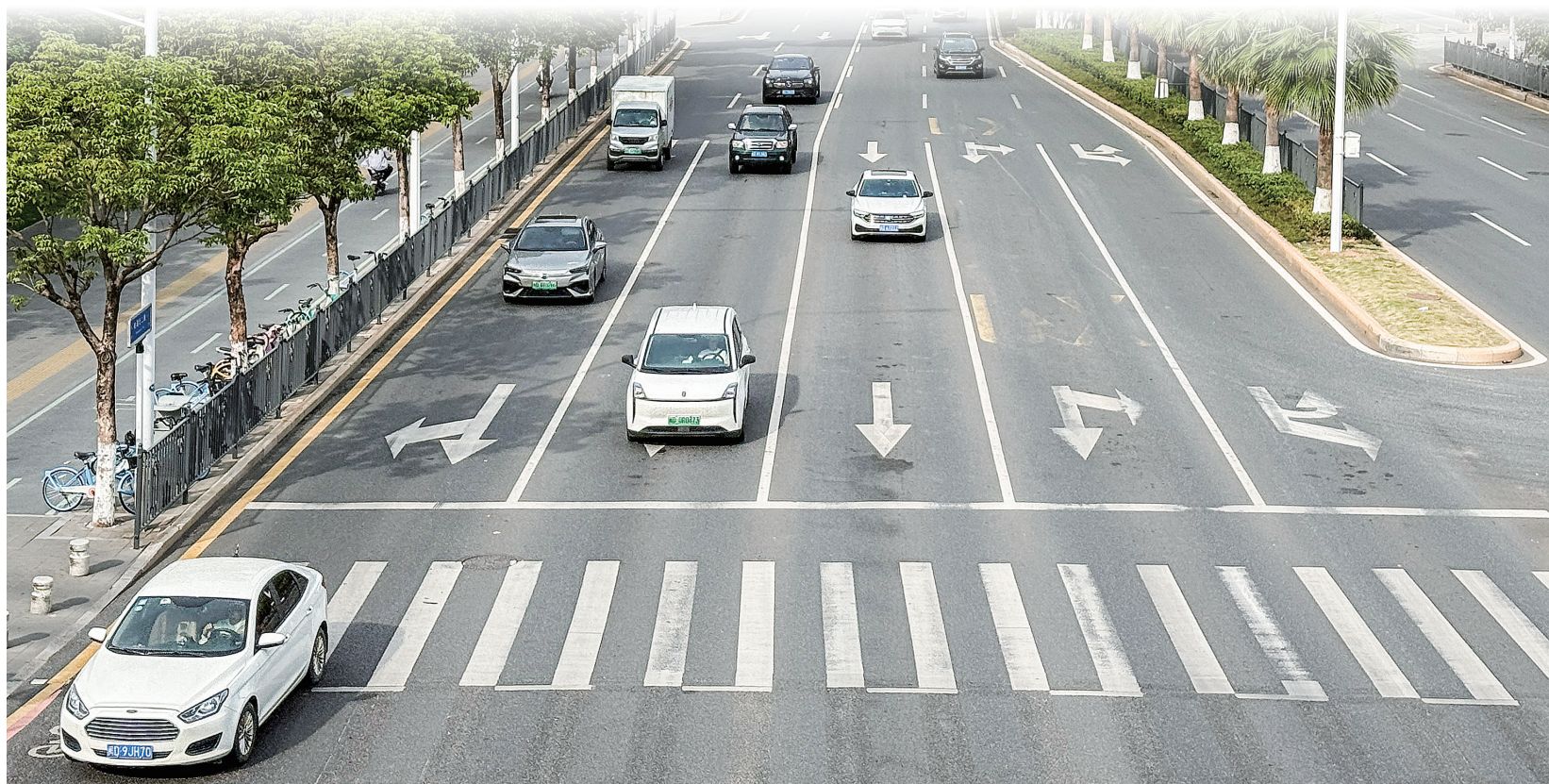
云顶北路与枋湖北二路交叉口东进口的右转车道改为直右车道,车辆通行更顺畅。记者 俞杰 摄
