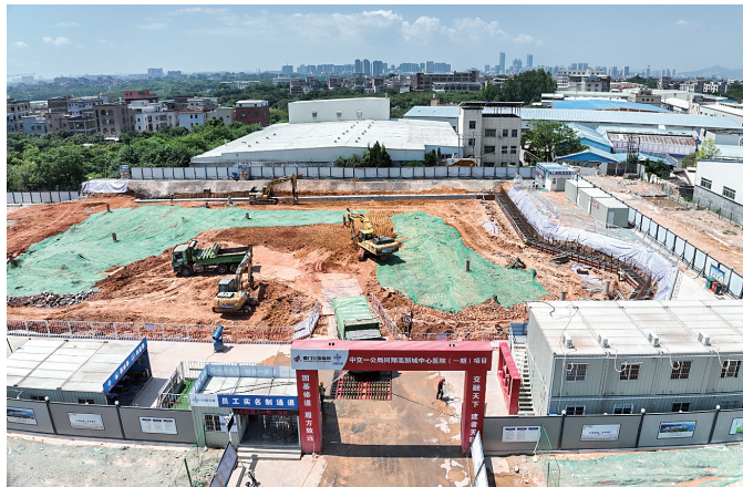
同翔高新城中心医院(一期)项目桩基施工完工。
