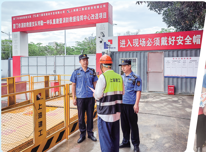
高考期间,思明区机动大队执法人员到工地巡查。
